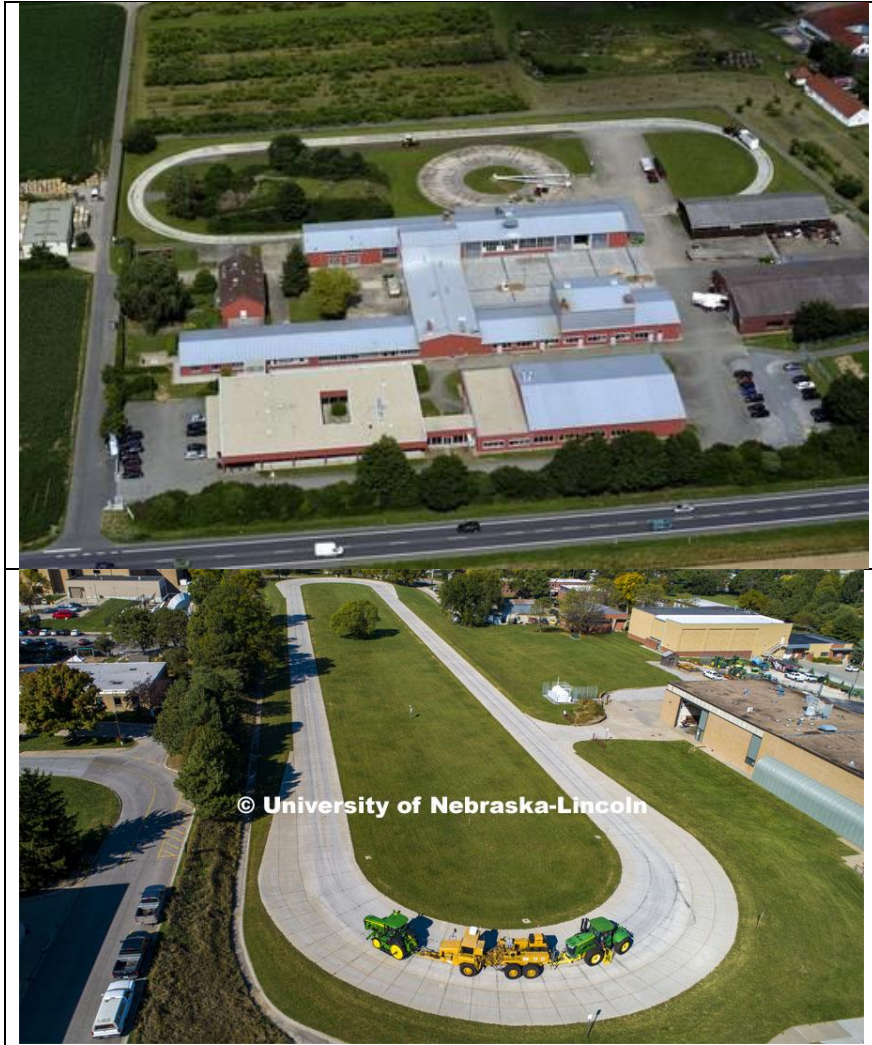
Figura 15.- Arriba: Estación de ensayos de la DLG en Alemania. Abajo, la de Nebraska (USA)
