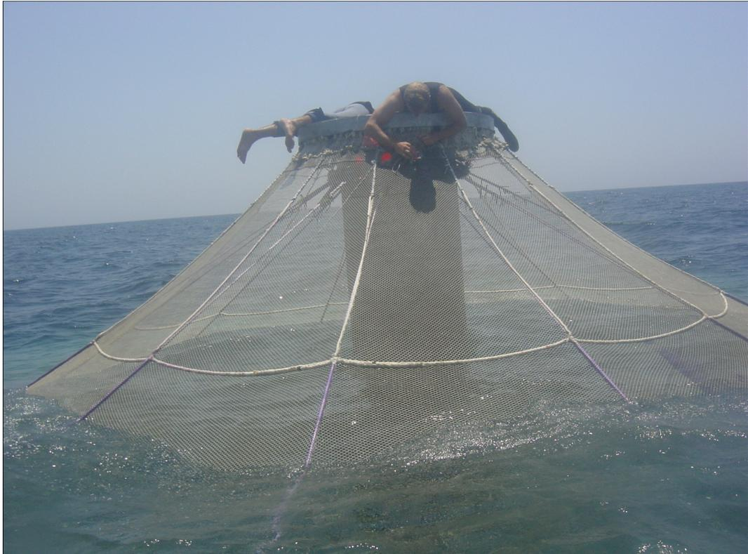
Figura 11. Finalización de la conexión superior de la red con el cilindro central. Esta conexión se realiza cosiendo la red a una pieza de red de alta resistencia que esta fija en la jaula. Esta es la única parte de la jaula donde la red carece de tensión.
