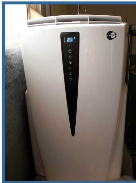
Figura 27. Sistema de aire acondicionado usado para el control de la temperatura del aire y agua en la sala de cultivo (Ref.: WAP-357EM/EMH, 1250W)
